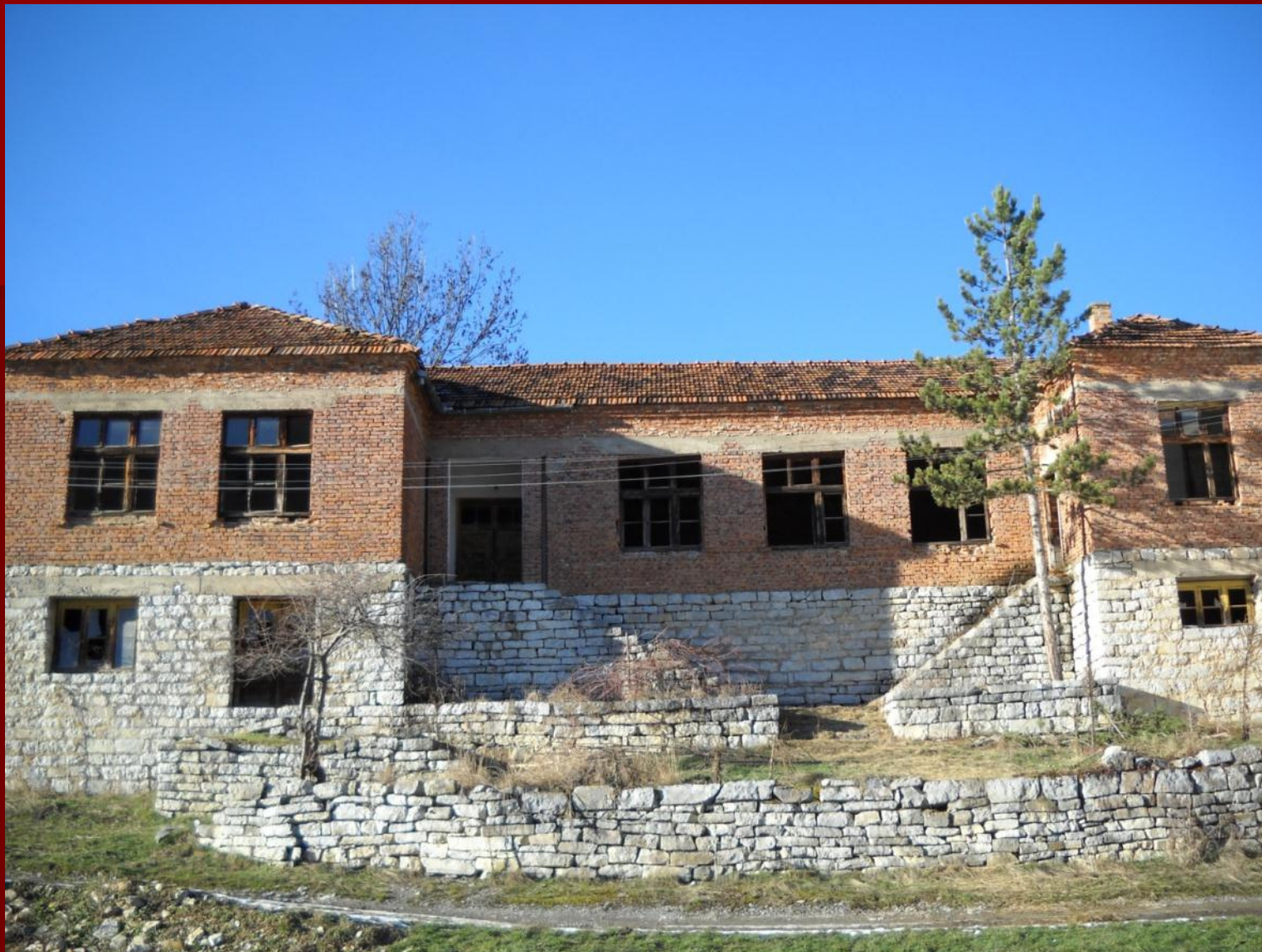
Izgled bivše šole pre početka radova
